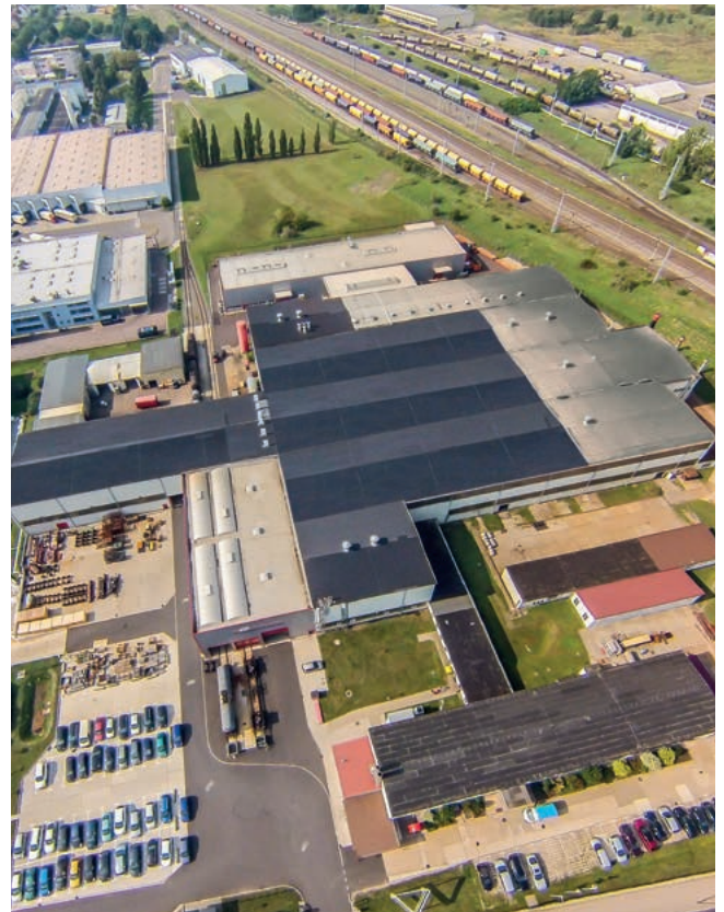
TIP TOP Oberflächenschutz Elbe GmbH in Wittenberg
