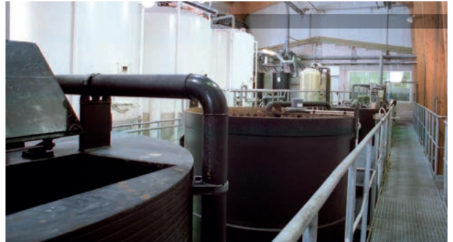
PE sewage plant
